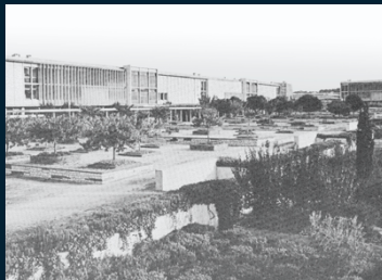
Site avant construction du Bâtiment 31. Source DPI (Direction du Patrimoine Immobilier de l'Université de Montpellier)
