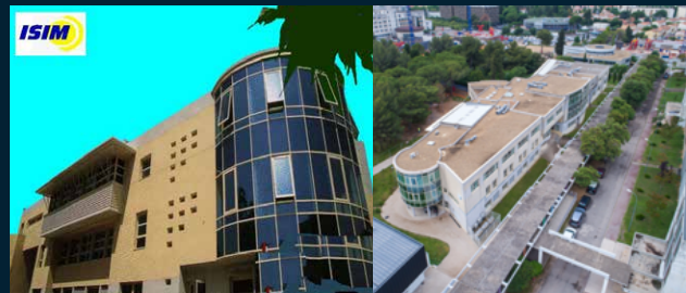
Le bâtiment 31 en 1996 et en 2018.
