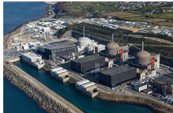
View of Nuclear Power Plants of Flamanville (Source : EDF Médiathèque)
