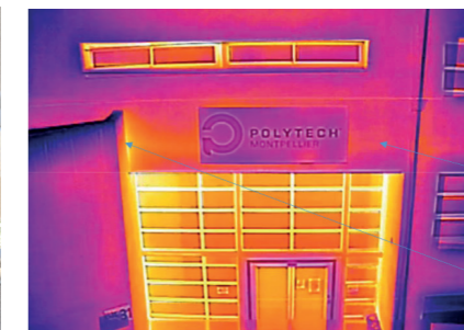
Analyse thermographique du bâtiment principal - mars 2021
