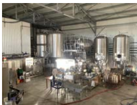
Entrepôt de production
